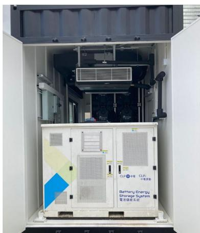
中電源動特別為 BIM CAVE 設計適合移動和較小規模的電池儲能系統（BESS），體積及重量是標準的電池儲能系統約兩成，更輕便靈活，取替以往以柴油發電機為 BIM CAVE 供電，有助減低碳排放。
