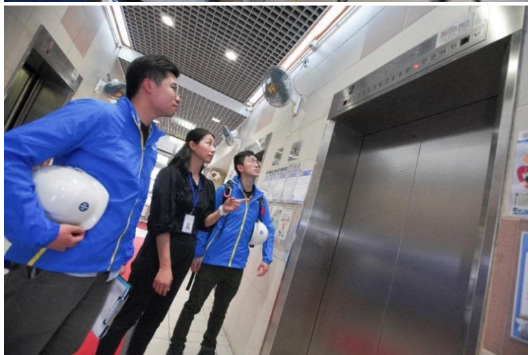
中華電力的電力質量團隊為創毅管理的其中一個屋苑進行實地視察，協助屋苑測試電力設備，並透過交流分享加強物管人員在遇上電力事故時的應變能力。
