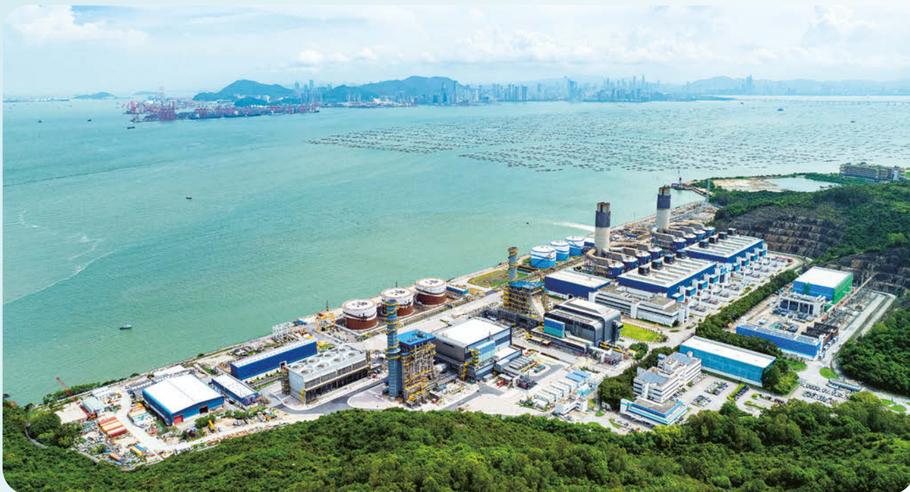
■ 位於龍鼓灘發電廠的新聯合循環燃氣渦輪發電機組是減少碳排放和確保香港可靠供電的關鍵基礎設施。
