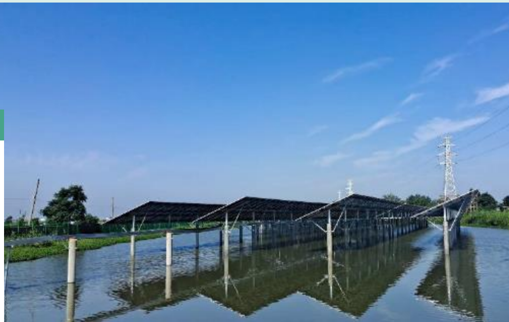
中国江苏省的扬州公道太阳能光伏电站
